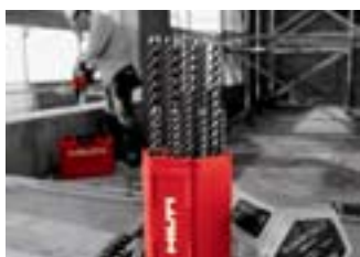
Wiercenie otworów pod kotwy
